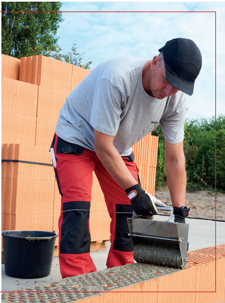
Szlifowane pustaki ceramiczne murowane na zaprawie do cienkich spoin Fot. 12.
