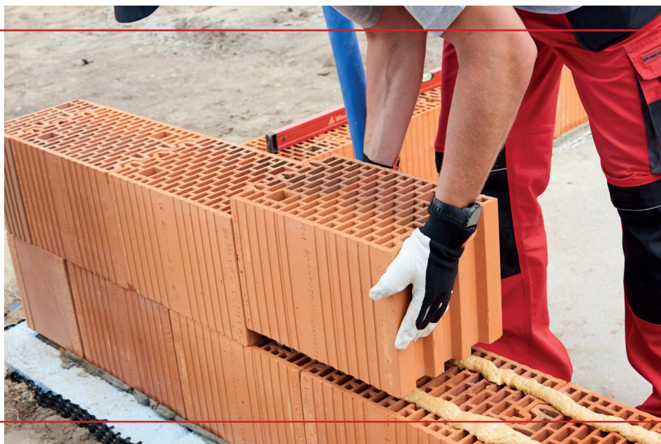
Szlifowane pustaki ceramiczne murowane na kleju poliuretanowym Fot. 13.
