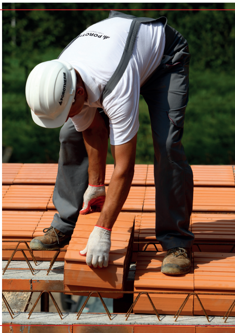
Fot. 19. Ceramiczny strop gęstożebrowy
