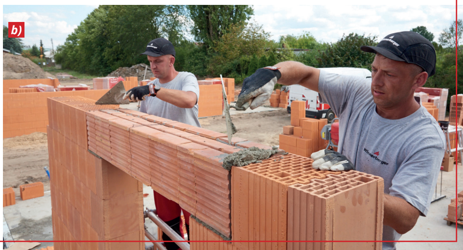
Prefabrykaty nadprożowe z zastosowaniem kształtek ceramicznych: Fot. 21.
